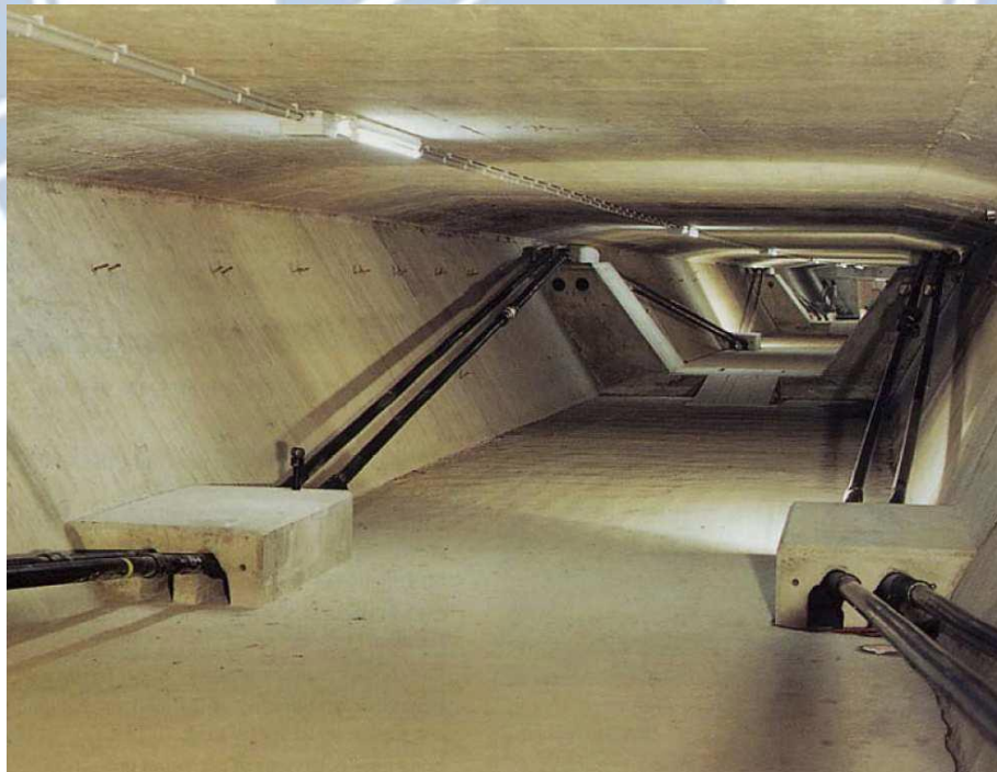
圖 2.4 外置預力橋樑內部 (Hermann Weiher et al, 2006) [13]
