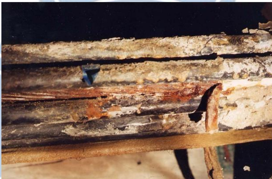
圖 2.2 外置預力鋼腱鏽蝕（G.M. Clark，2012）[9]
